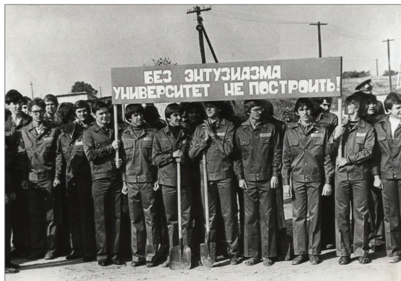
Студенты и преподаватели приняли участие в строительстве университета
